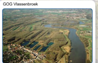
Vlassenbroekse Polder (Dendermonde): ruimte voor gecontroleerd overstromingsgebied, waarvan een deel met gereduceerd getij.
